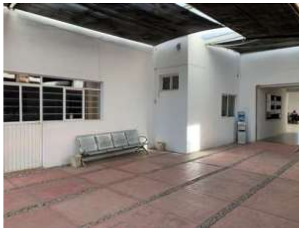
Ilustración 2. 4 Evidencia falta de señalizaciones. Fuente: Distrito SAGARPA
